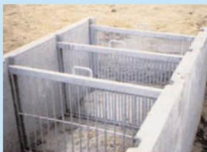
GRILLES DROITES ET INCLINÉES GALVA POUR PECHERIES AVAL OU AMONT
